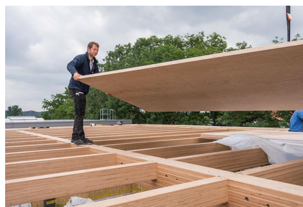
Abbildungen 17 – 20: Bürogebäude der euregon AG, Augsburg, lttkearchitekten bda, Skelettbau: Stützen, Haupt- und Nebenträger aus BauBuche GL75, Deckenplatte BauBuche Q, Fotos: Eckhart Matthäus
