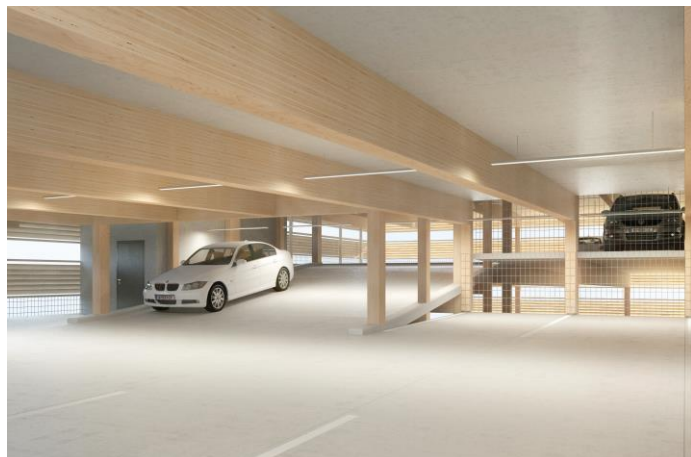
Abbildung 16: BauBuche Projektbeispiel / Visualisierung Parkhaus Unterzüge und Stützen aus BauBuche GL70, Deckenuntersicht aus BauBuche Platten. Forschungsprojekt der TUM.Wood unter Beteiligung der Professoren
