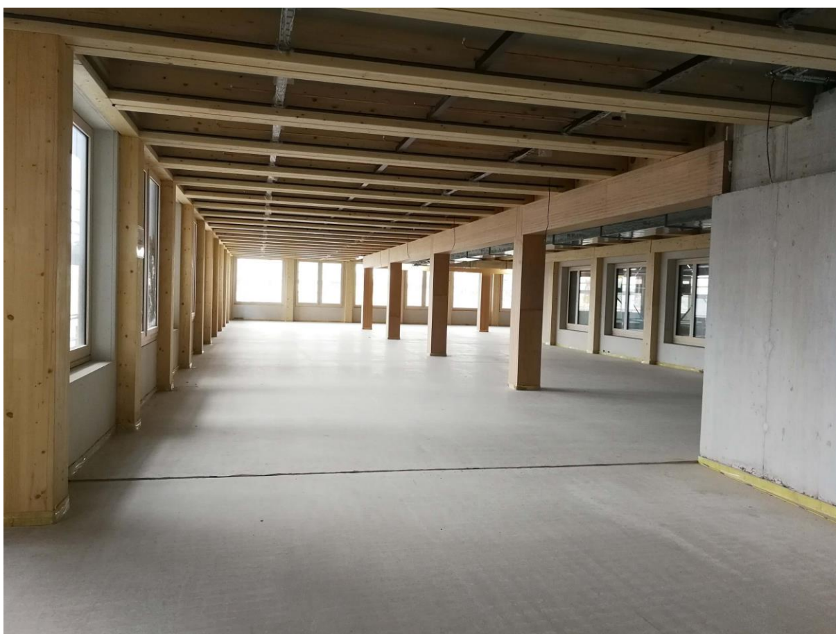
Abbildungen 30 – 31: Erstes Schweizer Holzhochhaus, Rotkreuz, Burkhard Meyer Architekten BSA, Stützen und Unterzüge aus BauBuche GL75, Fotos: Markus Bertschi
