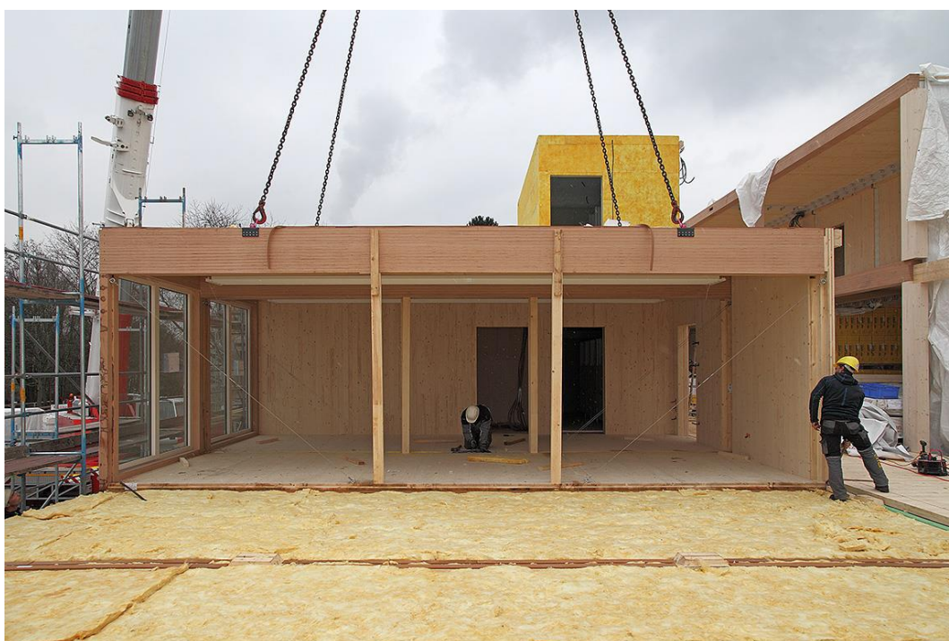
Abbildungen 26-27: Europäische Schule Frankfurt, Anbau in Modulbauweise, Architektur: NKBAK Stützen und Unterzüge aus BauBuche GL75, Foto: Thomas Meyer
