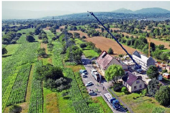
Das Wasserwerk Rauental muss umgebaut und erweitert werden, um das belastete Trinkwasser reinigen zu können. Foto:
