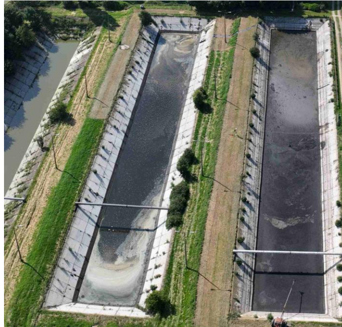
Rechtecktrapezbehälter 110 x 21 m
