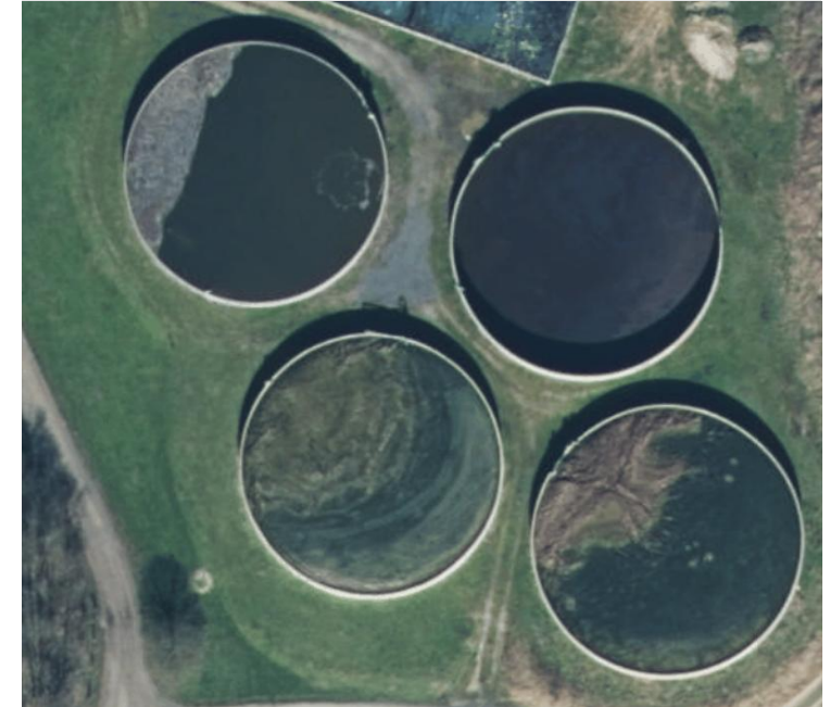
Rundbehälter Ø 24 - 40 m
