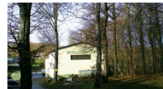
Biogasanlage in Pahren (Foto: Pahren Agrar GmbH & Co.)
