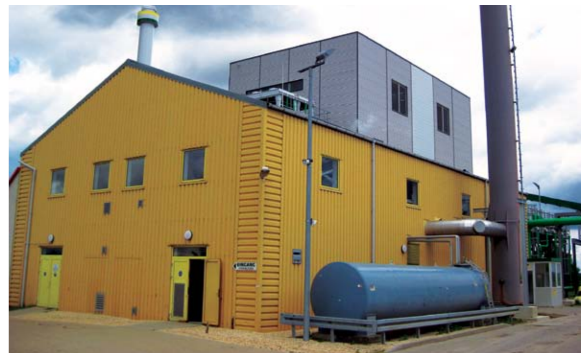
Biomasseheizkraftwerk in Schkölen (Foto: BIOBETH)
