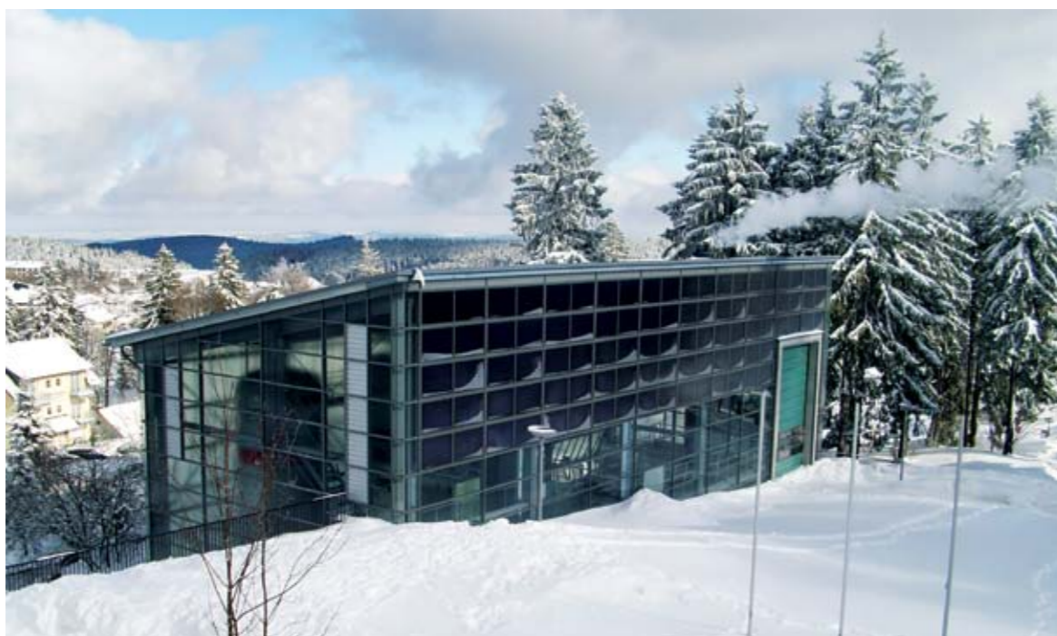
Heizhaus in Oberhof (Foto: TMBLV)
