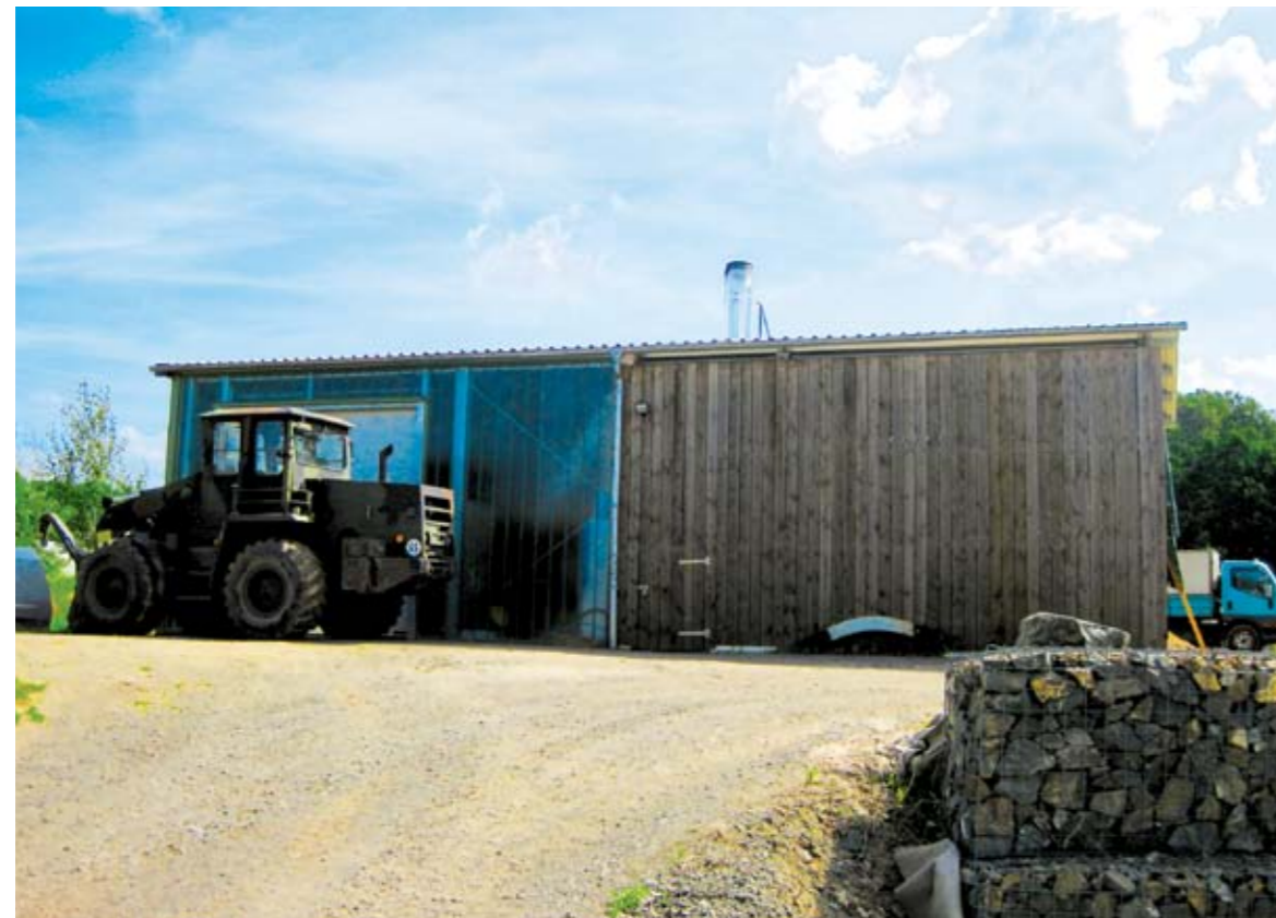
Außenansicht der Holzhackschnittelheizanlage in Burkersdorf (Foto: BIOBETH)
