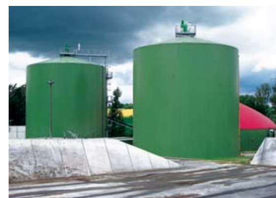
Biogasanlage Schkölen (Foto: BIOBETH)
