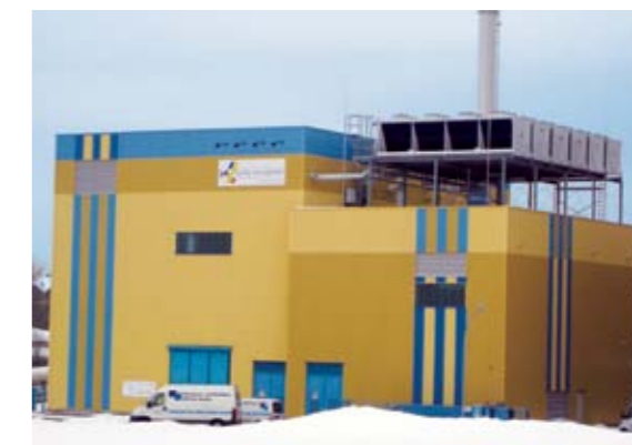
Biomasseheizkraftwerk Hermsdorf (Foto: TLL)
