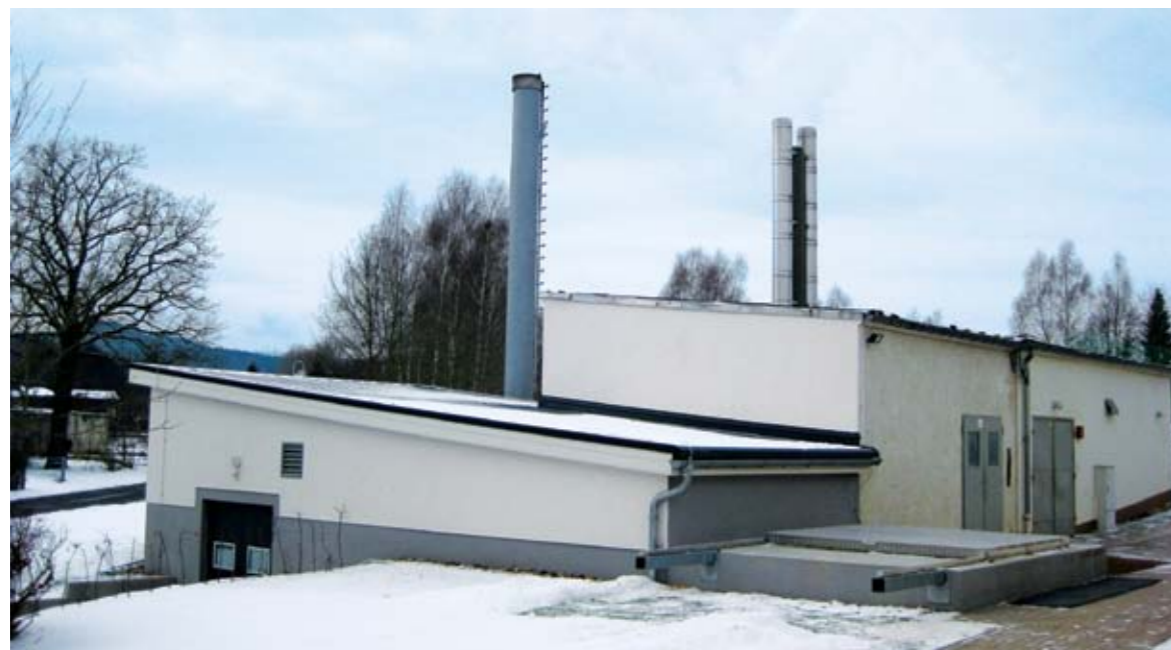
Heizhaus in Breitungen (Foto: BIOBETH)
