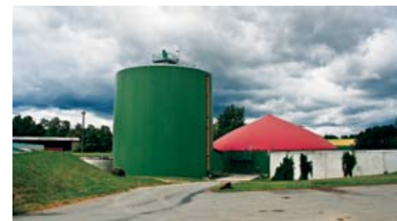
Biogasanlage in Schkölen (Foto: Bioenergieregion Jena-Saale-Holzland)
