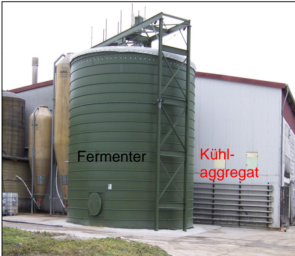
Fermenter (400 m 3 ) mit vorgelagerter Hygienisierung in SM-Betrieb FLESIMA/LWD
